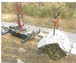
岩石吊だし装置「ツレール君」
